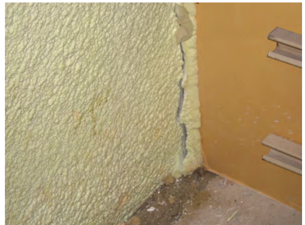
裏側(左は外壁ECP、右は間仕切壁)
